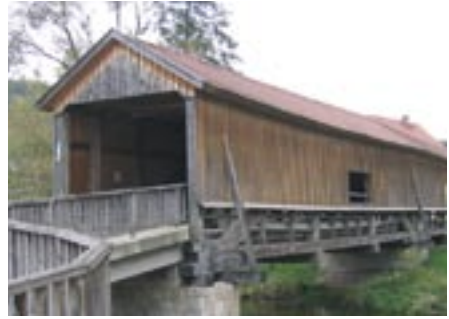
Historische Holzbrücke über die Ilm in Buchfart
