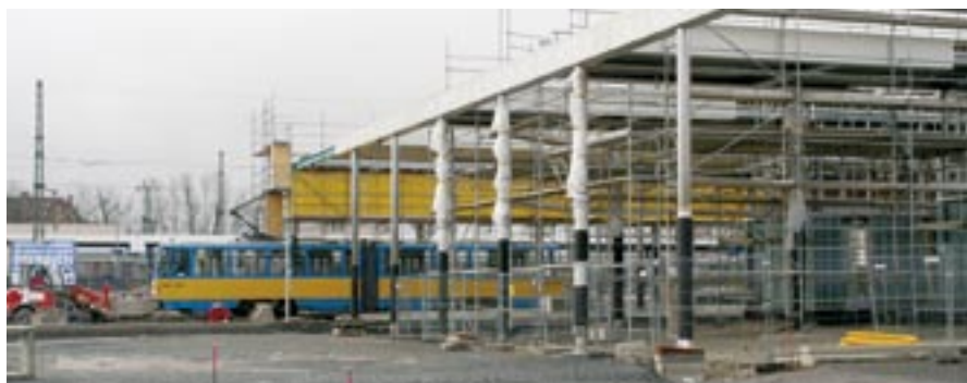
Musterbeispiel für eine Verknüpfung des ÖPNV: der neue Verkehrsterminal in Gotha.
