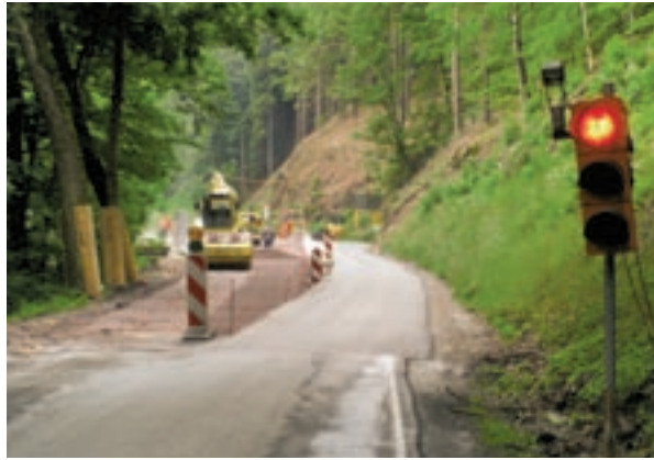
Keine Umleitung, aber mit Ampelregelung durch die Baustelle.
