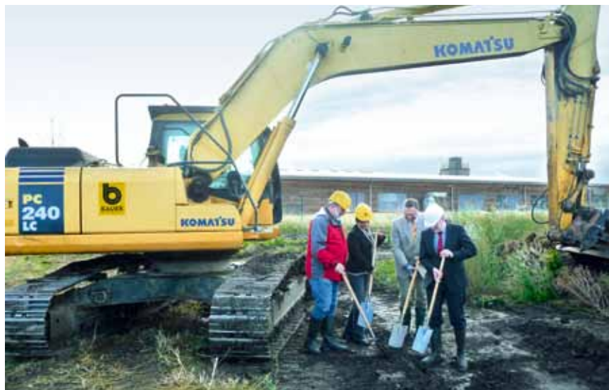
Spaten schwingen für einen neuen Busbetriebshof.
